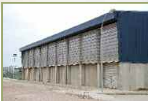
Arreglo del Pabellón Municipal de deportes
