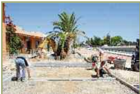
Obras en Avda. de la Cruz
