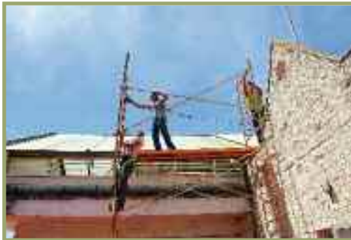
Arreglo de la cubierta del C.E.I.P. Ana Josefa Mateos
