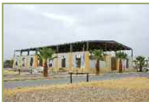
Obras del Pabellón Multiusos en el recinto ferial
