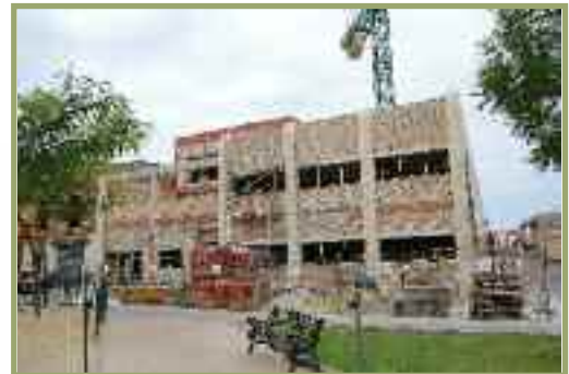
Obra de la futura Guardería Municipal
