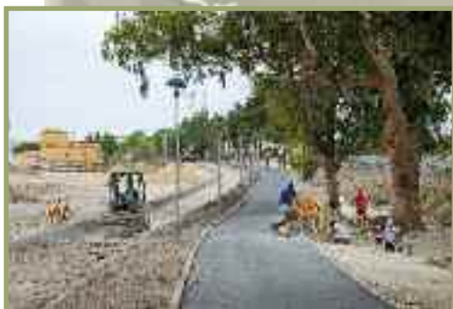
Obras de acceso al Polideportivo Municipal
