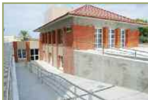
Obras de acceso a la Casa de la Juventud
