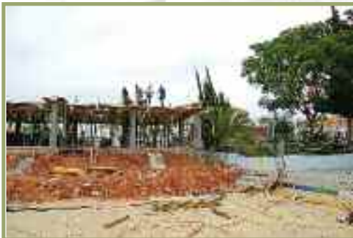
Obras en C.E.I.P. El Pinar
