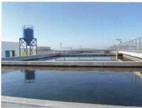
Visita Depuradora de Aguas
