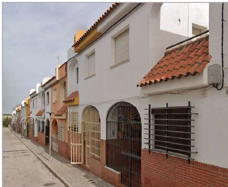
Vista de viviendas adosadas en C/ Cordillera.
