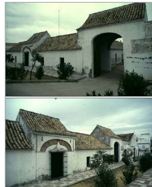
Imagen de la Casa de Postas anterior a su reciente rehabilitación.
