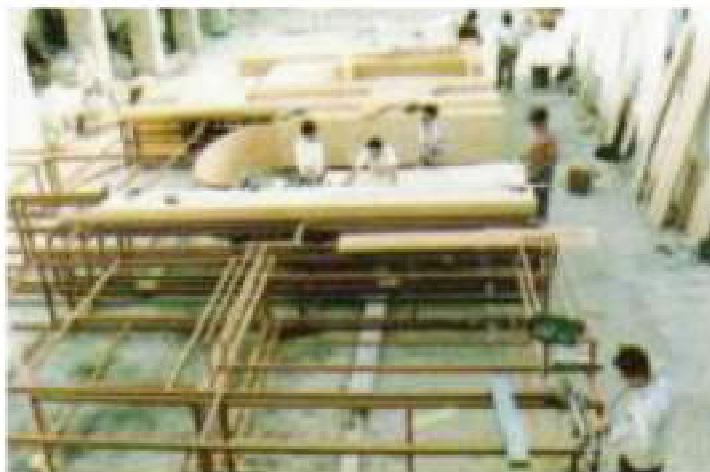
Momento de la construcción de la portada. 1993.
